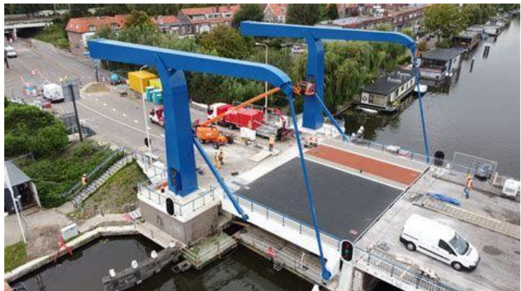
Een referentieproject: renovatie van de Leidse Churchillbrug
